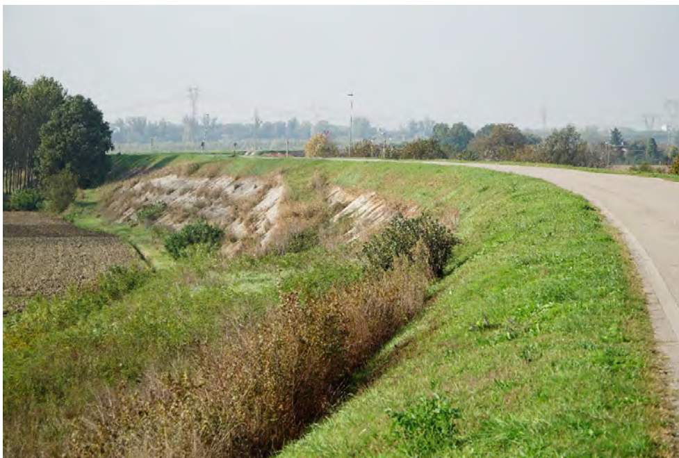
Figura 2-7: esempio di rivestimento in lastre in cls sul paramento lato fiume lungo il tratto oggetto di intervento
